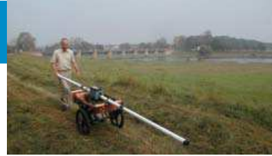
Geophysikalische Messung zur Zustandsbewertung von Flussscheiden Foto: Technische Fachhochschule Wildau
